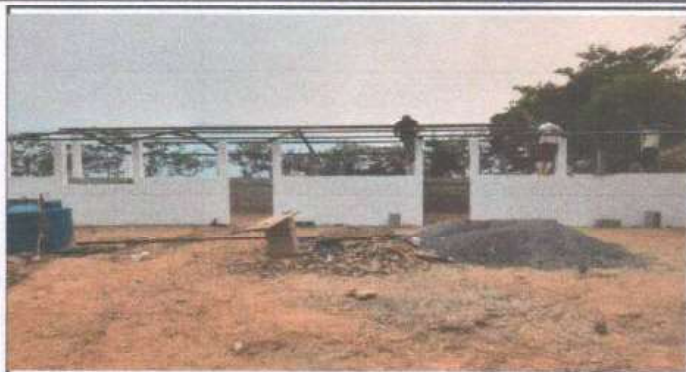
Foto 1: Se observa la colocación de las estructuras metálicas de la cocina y bodega.
