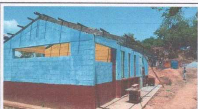
Foto 4: Se observa el mantenimiento de los balcones, puertas del establecimiento.
