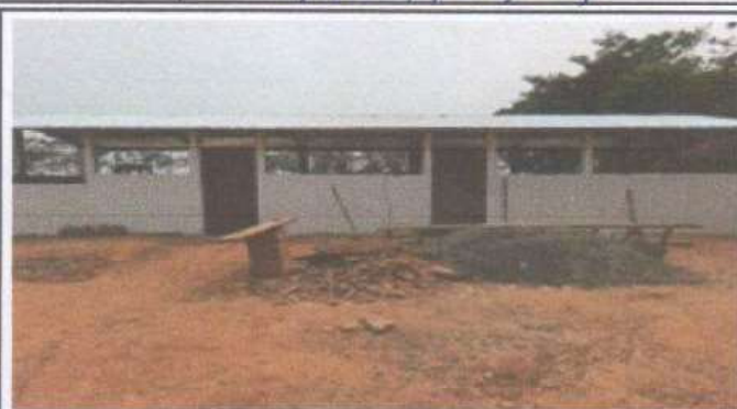
Foto 2: Se observan las dos puertas que se colocaron.
