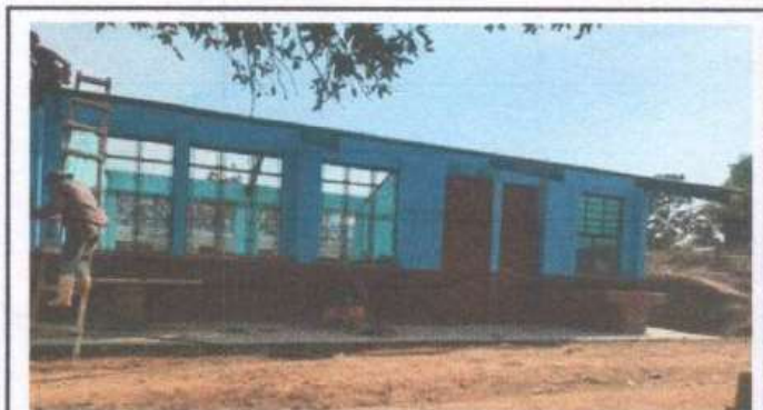
Foto 3: Se observa el mantenimiento de las costaneras.
